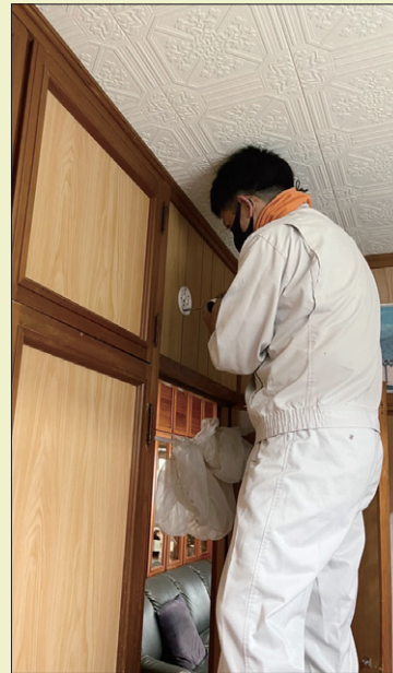
取り付け作業
