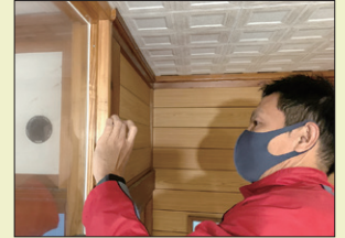
取り付け作業
